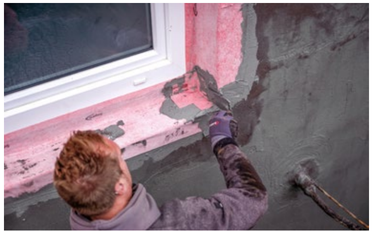
Nachträgliche Bauwerksabdichtung von außen mit zementärer Dichtungsschlämme bis auf Höhe 30 cm über GOK mit Anschluss an vorhandene Kellerfenster.
